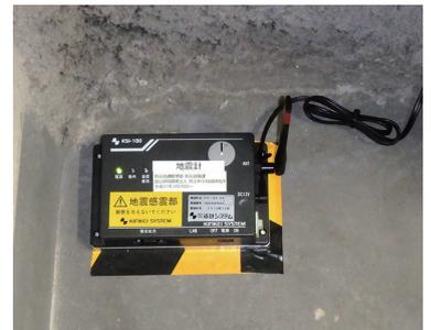
図1 地震計の設置例(EPS内)
